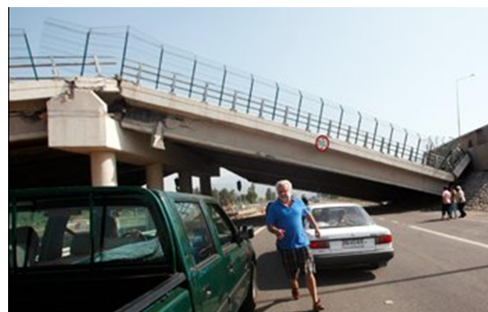
Рис. 2 Разрушение путепровода при землетрясении в Чили
