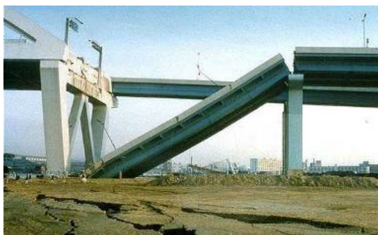
Рис. 1 Разрушение транспортной эстакады при землетрясении в Кобе (Япония)
