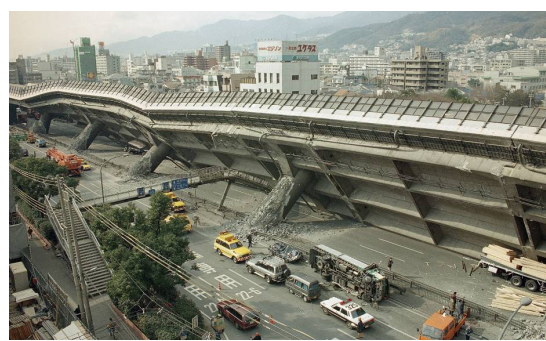
Рис. 1 Разрушение транспортной эстакады при землетрясении в Кобе (Япония)
